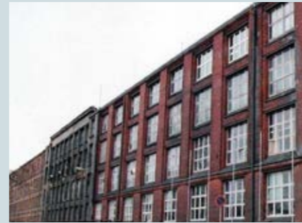
1992 Diamantwerk vor der Sanierung
